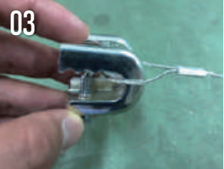
パイラックにワイヤー片側を 圧着端子で固定
