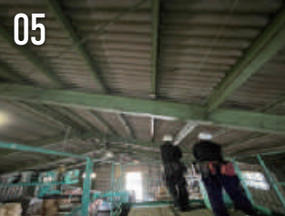
ワイヤーをH網の上に通し 水平になるようはわせる
