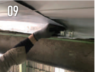
軒先⇄棟どちらかの方向から シートをはわした後にシートを H網にパイラックを使用して固定
