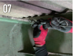
セットしたパイラックをH網に 取付、ターンバックルで締め上げる
