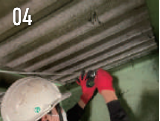
固定したパイラックを H網に取り付ける
